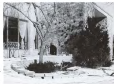
New Commons handicap ramp in progress...
